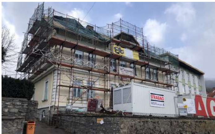
An der alten Villa an der Kindberger Hauptstraße wird gerade fleißig gearbeitet. Im September sollen die Schlüssel übergeben werden. Foto: Hofbauer
